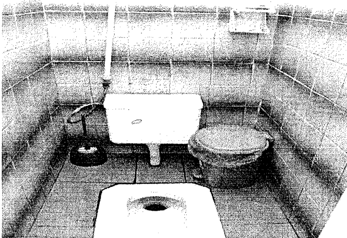
Фото № 17 Санитарно-гигиеническое помещение
