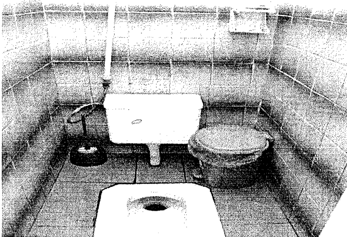
Фото № 17 Санитарно-гигиеническое помещение
